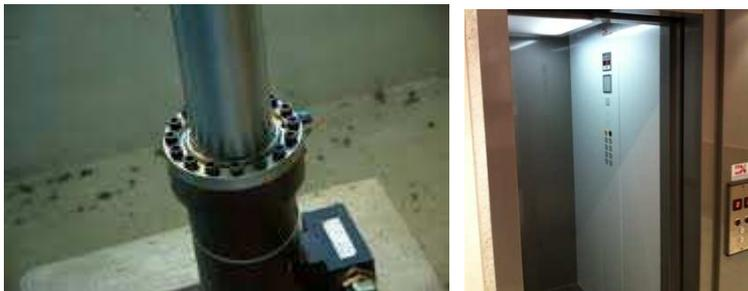
Gli ascensori, della ditta Emmeci Lift di Arconate, saranno realizzati con pistone oleodinamico azionato da motore collocato a ridosso del vano in cemento armato, avranno la cabina con portata da 450Kg/ 6 persone di dimensioni 950x1300 e svilupperanno un percorso di n. 5 fermate.
